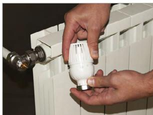
**1)** Aprire completamente la testa portando la manopola in posizione \*.
