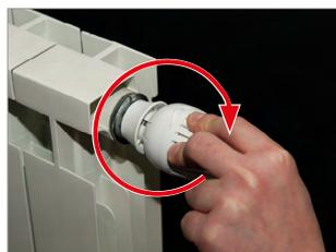
**3)** Chiudere a fondo la testa ruotando la manopola (portare la manopola in posizione **\***).
