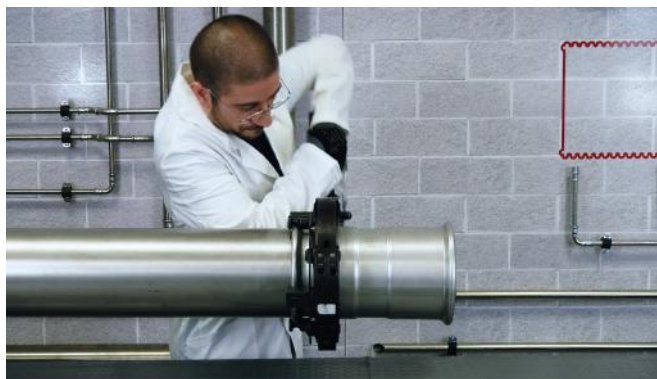
Figura 29 – Assemblaggio pressatura n°2
