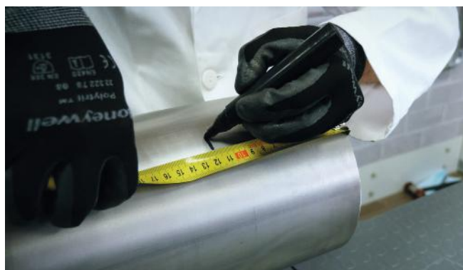
Figura 22 a - Marcatura della profondità d'innesto Oversize
