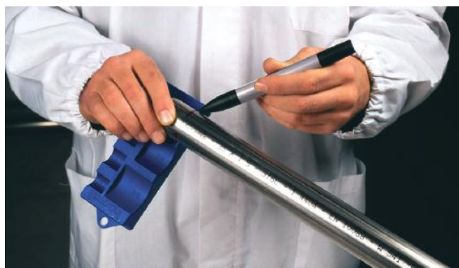
Figura 22 - Marcatura della profondità d'innesto
