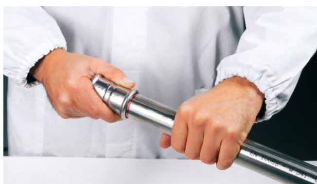
Figura 25 - Inserimento del tubo nel raccordo a pressare
