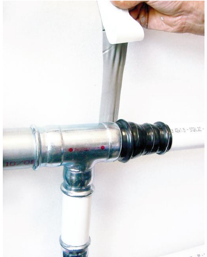
Figura 32 - Protezione dei raccordi con nastro isobutilico
