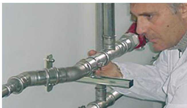
Figura 27 - Controllo della pressatura
