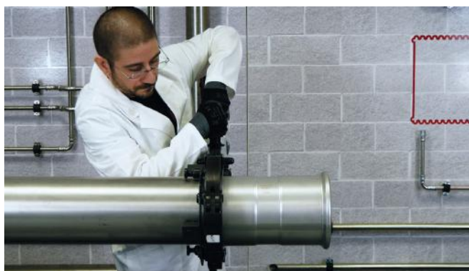
Figura 28 – Assemblaggio pressatura n°1
