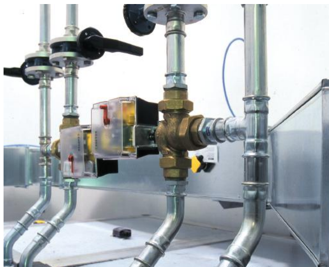
Figura 16 - StormSTEEL - Acqua di raffreddamento
